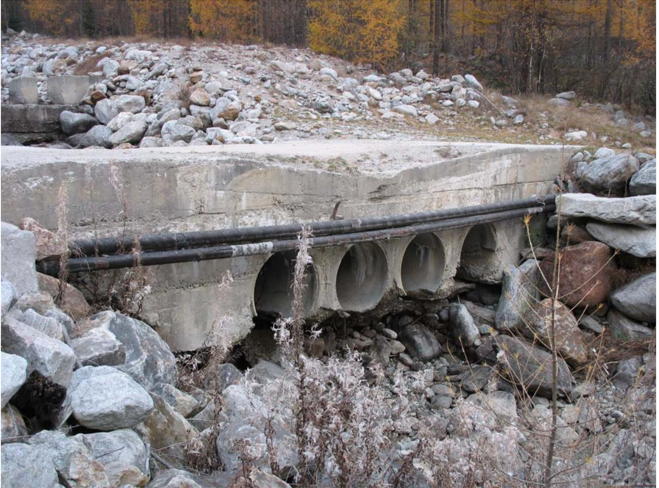
Rio Roffel: il guado esistente soggetto a scalzamento, da ricostruire con sezione più ampia.
